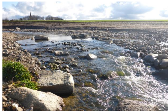
Sten och grus har tillförts ån för att gynna fisken Foto: Tullstorpsåprojektet
