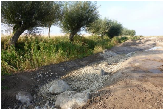
Sten och grus har tillförts ån för att gynna fisken Foto: Tullstorpsåprojektet
